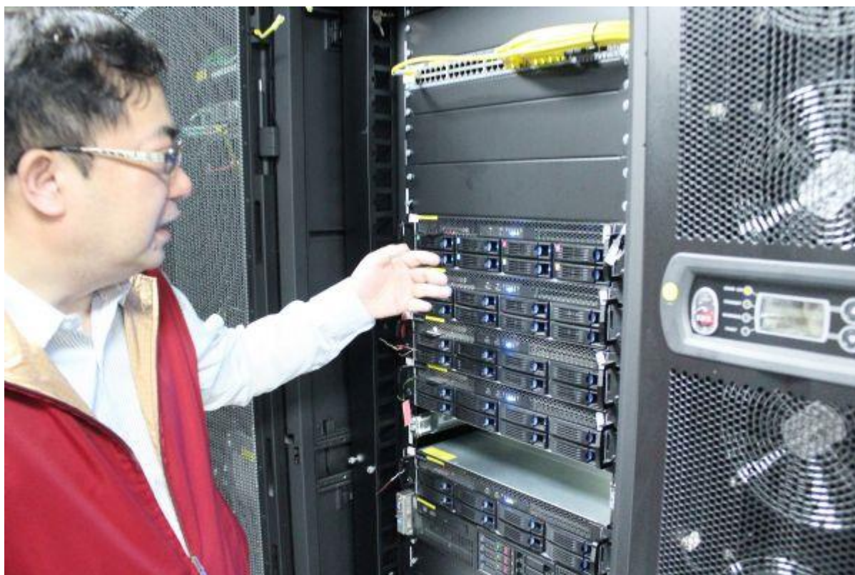
資源管理組長林克偉表示，機器背後是所謂的熱通道，冷氣是要吹前方讓熱氣往後排，才能達到降溫效果。
